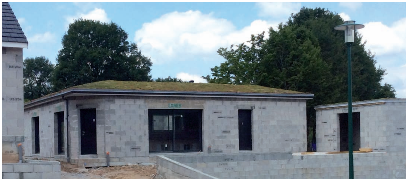
Dotée de performances thermiques et mécaniques, la 5.000 e maison, réalisée par Coreb, en blocs isolants Alkern.
