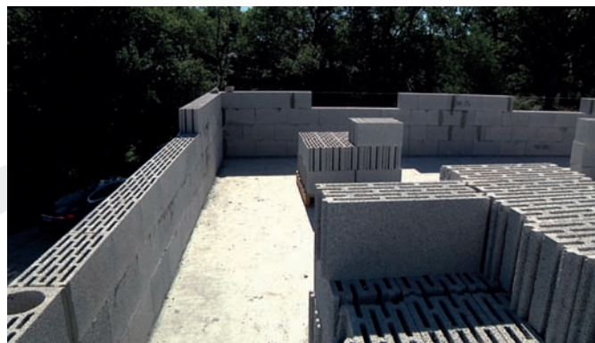
Montage des premiers rangs de blocs isolants VTherm Alkern.
