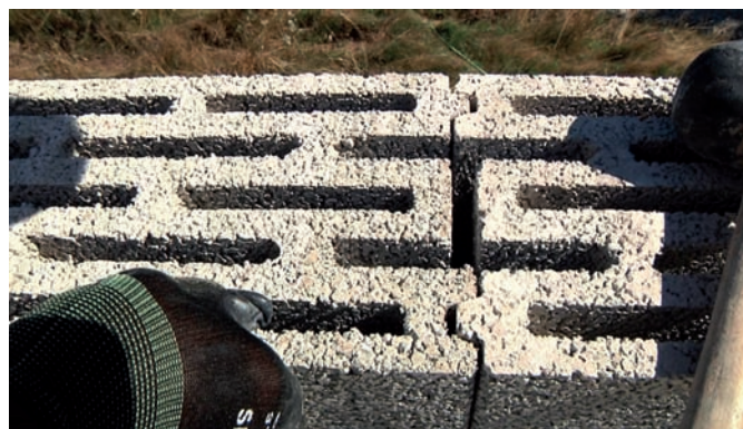
La mise en œuvre des blocs VTherm Alkern est grandement facilitée par l'emboîtement vertical.
