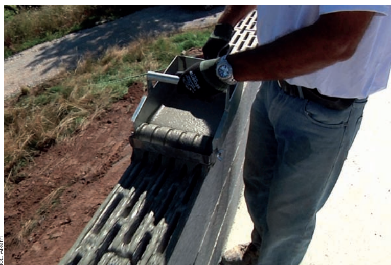
Application au rouleau du mortier colle sur le bloc isolant VTherm Alkern.
